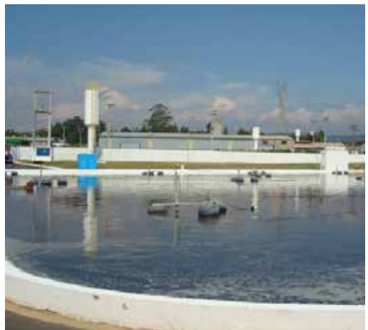
Ampliação da Estação de Tratamento de Esgoto de Cabreúva
